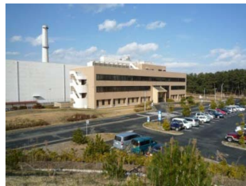
被災度判定調査を実施 (A棟中破*、B棟:軽微*)
