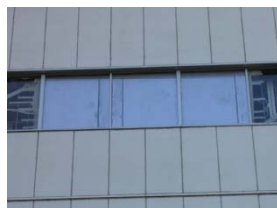
合板による応急措置後 ステンレス板により窓を 復旧
