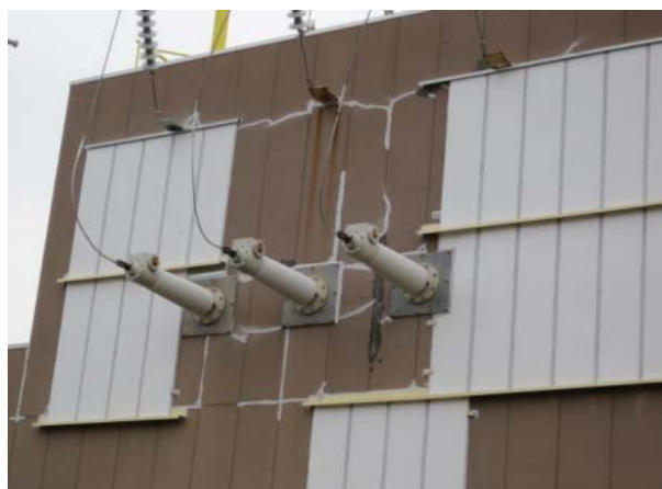
南受電所の応急措置の状況
