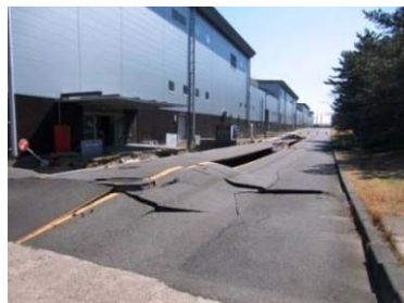
リニアック棟横の構内道路の状況
