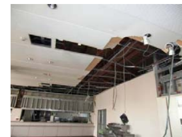
構内食堂2階の状況
